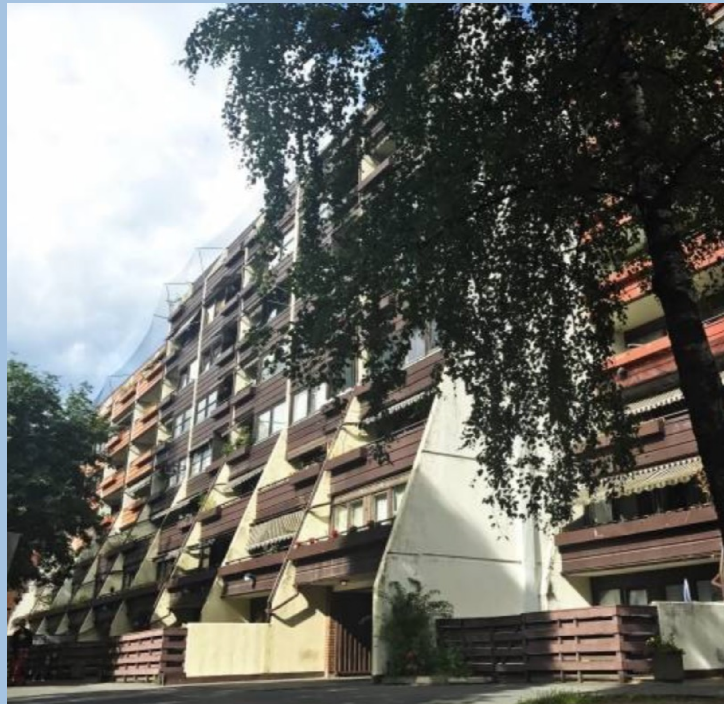
Rehabilitering av sosialboliger. Energiforbruket reduseres med 70%
