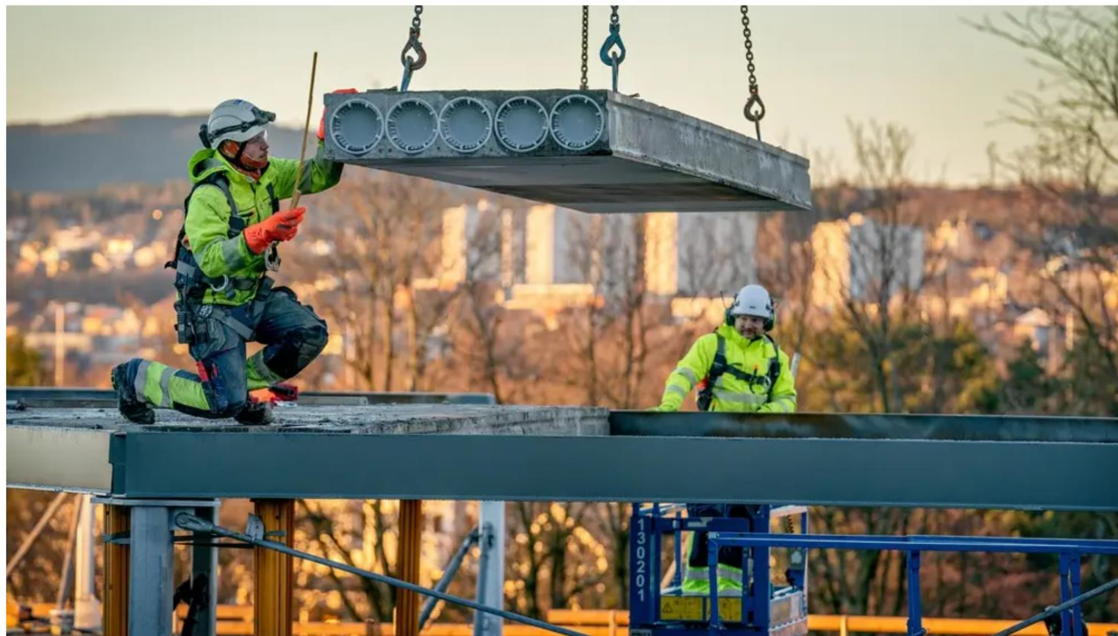
27 gamle hulldekker fra regjeringskvartalet er gitt nytt liv i ny storbylegevakt. Nå er norsk standard på plass basert på dette pilotprosjektet. Foto: Eirik Helland Urke
