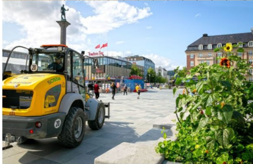
Tar form: Granittdekket er på plass på store deler av Torvet og flere nye utesteder har åpnet i løpet av sommeren, men fortsatt er det anleggsvirksomhet her. Den lydløse, elektriske hjullasteren er et synlig tegn på det.
