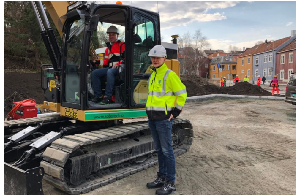
Endelig: Både Kristian Søbstad i Søbstad as og teknisk sjef Tomas Eldsmo i Trondheim kommune er godt fornøyd med at den første elektriske gravemaskina er i drift i Trondheim. Den passer godt i arbeidet med oppgradering av parkeringsplassen på Lillegårdsbakken. (Foto: Ingunn Grøtte)
