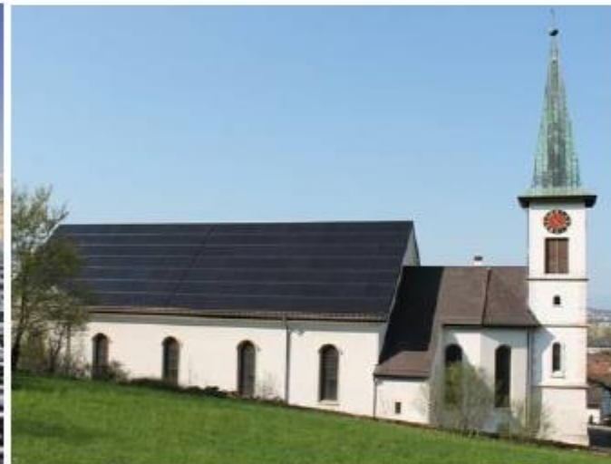
Katolsk Kirke, Ettingen, Sveits, 60 kW solcelleanlegg, lenke Bilde: Solvatec, 2013
