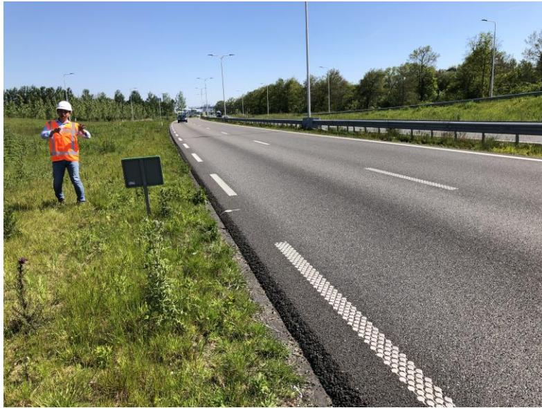
To-lags porøst dekke på motorvei 2016 93 % RA, 110 °C
