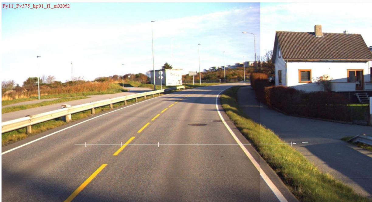
Fv 375 – Hp 1, km 1.420 – km 2.500
